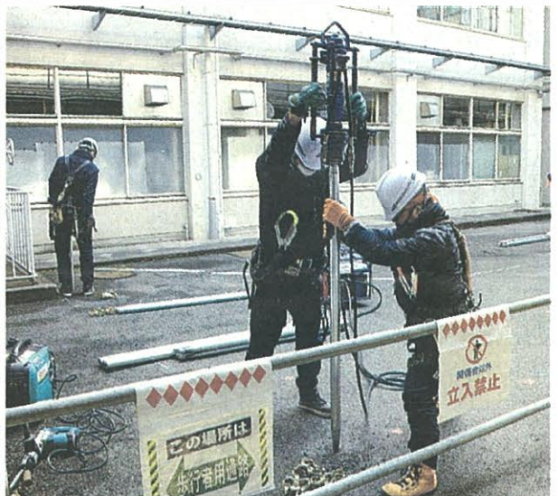
仮設駐車場の屋根を支える鉄パイプを打ち 込む工事請負業者—松江市末次町、市役所
